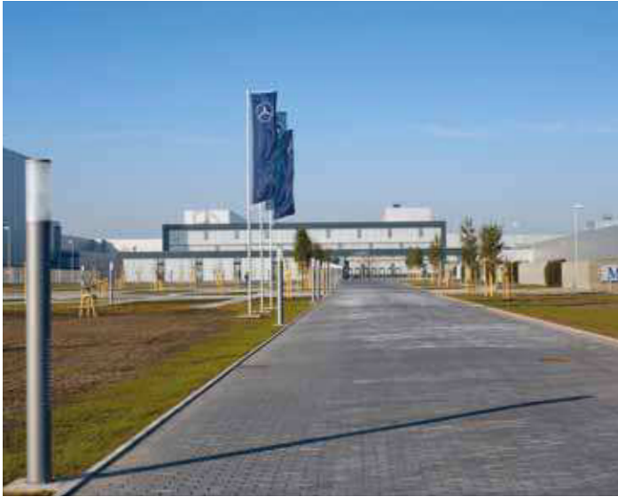
Herzstück der Anlage ist das Verwaltungsgebäude. Der Baukörper befindet sich in der zentralen Eingangszone ins Werksgelände.
