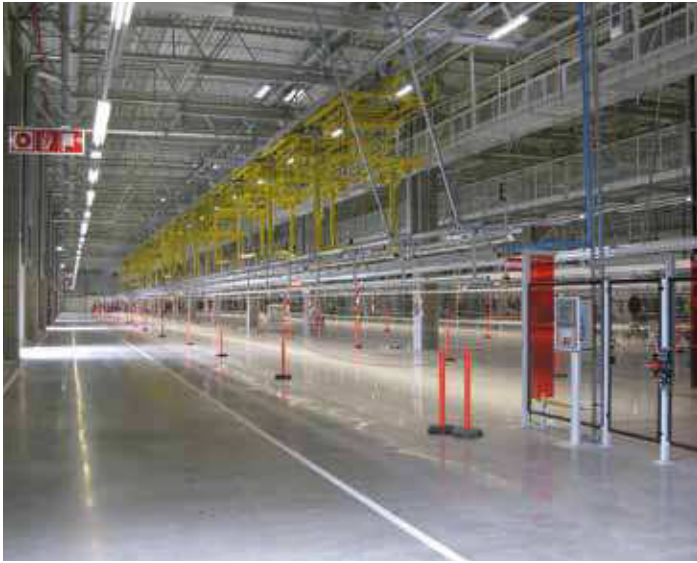
Das Innere der Montagehalle.
